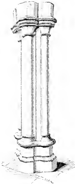
PIER: CLUSTERED PIER: OLD, NORTHAMPTONSHIRE: C. 1450.
